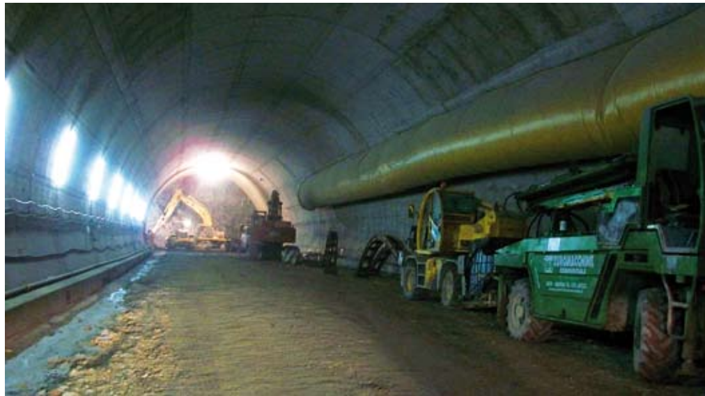
Galleria S. Michele: esecuzione scavo di avanzamento canna sud
