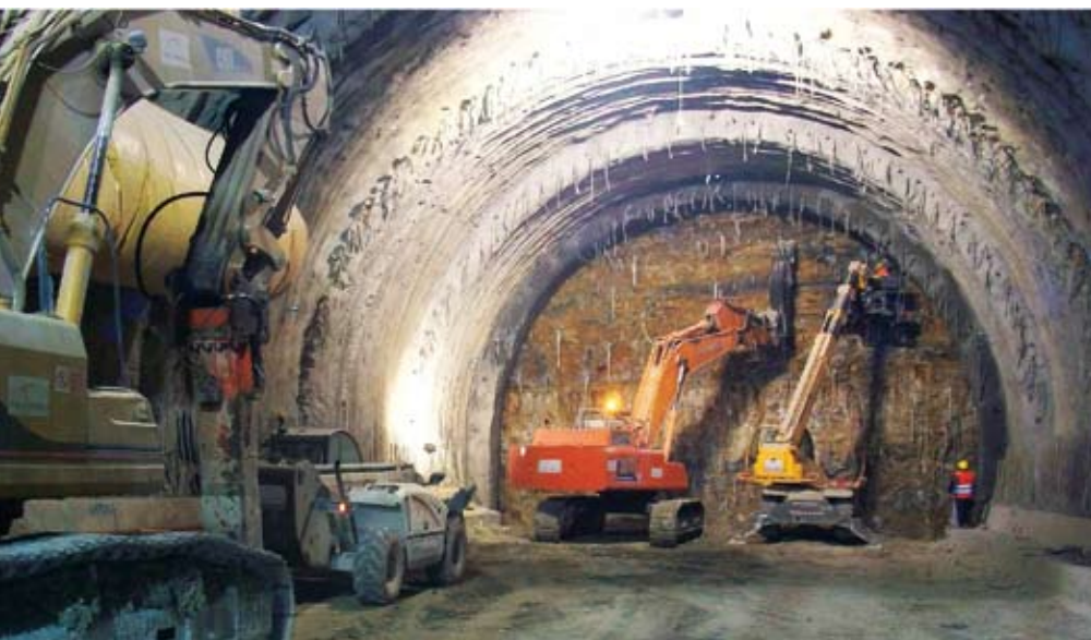
Galleria S. Angelo. Sopra, posa delle centine. In basso da sinistra, verifica piani e mezzeria; pre-spritz al fronte e spritz beton su centina
