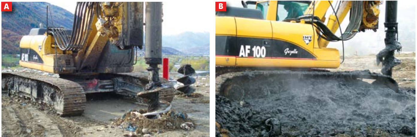
Figura 3 - Operazioni di trivellazione (A) ed estrazione di rifiuto a diverse profondità dalla superficie della discarica (B)
