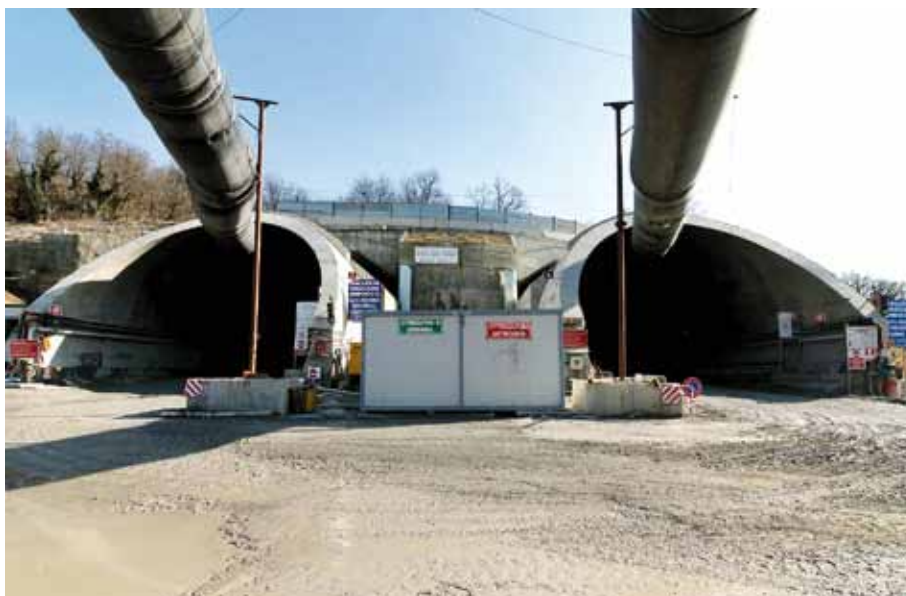
L'imbocco lato Bologna della galleria Grizzana, nel lotto 5a
