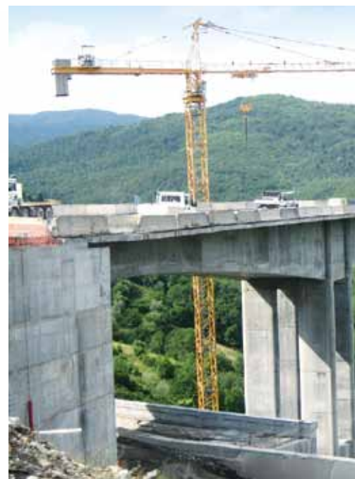
Veduta del viadotto Aglio, nel lotto 13
