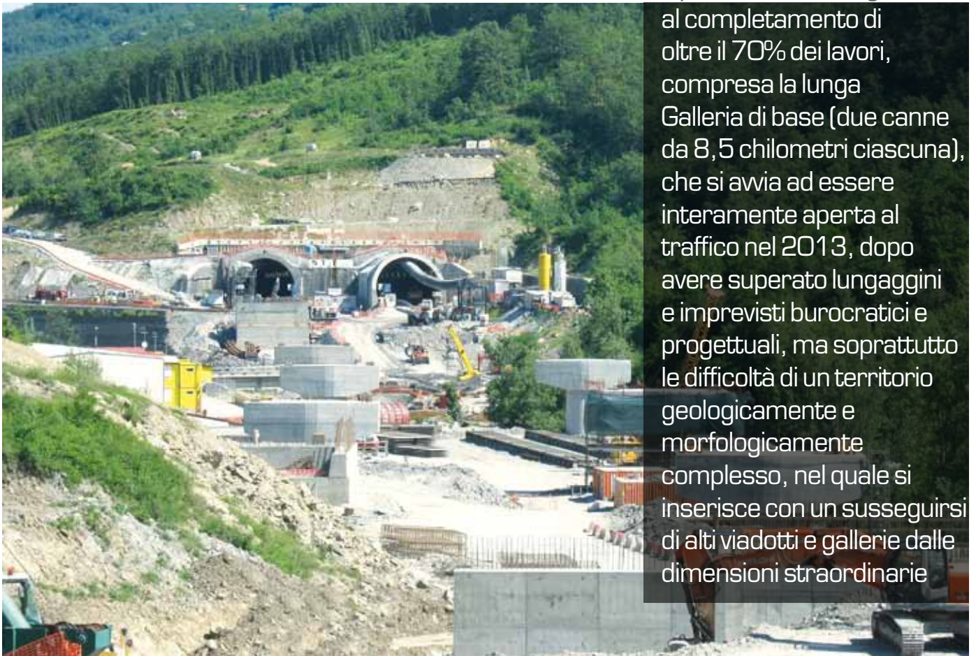
Veduta del viadotto Sparvo e dell'imbocco lato Firenze della galleria Val di Sambro, una delle più complesse del lotto 6-7 della Variante di Valico, fra le ultime ad essere completata
