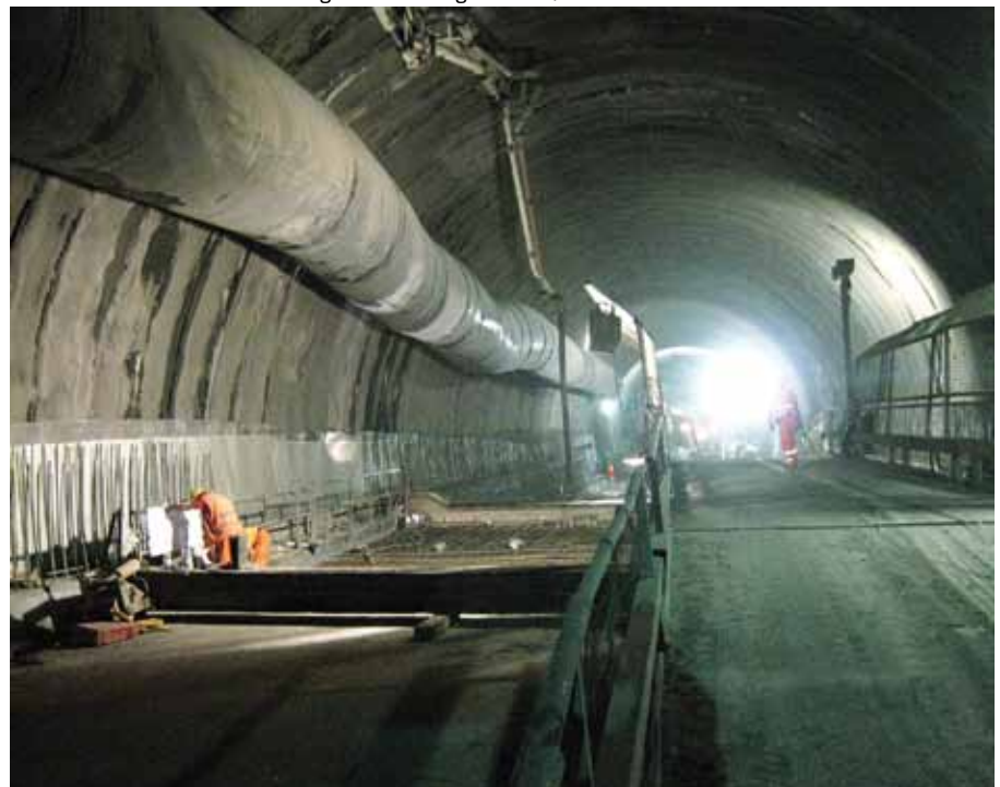
L'imbocco lato Firenze della galleria Manganaccia, nel lotto 13
