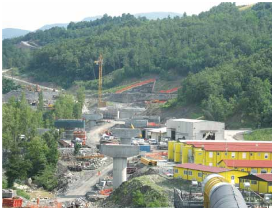
Veduta del viadotto Sparvo e della paratia d'imbocco lato Bologna della galleria omonima, nel lotto 6-7
