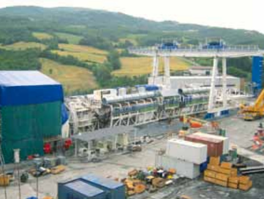
Montaggio della fresa che scaverà la galleria Sparvo, nel lotto 6-7
