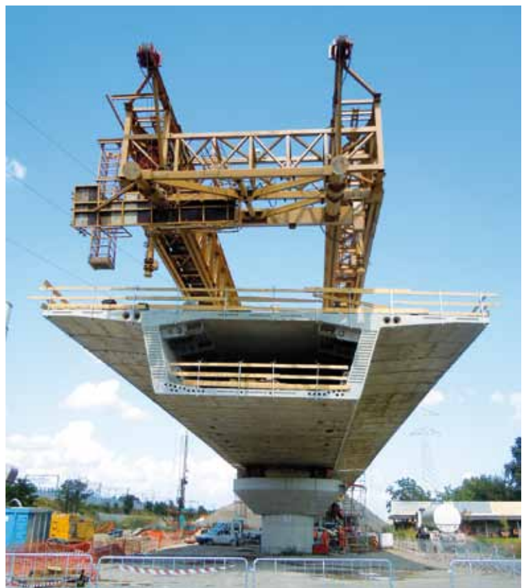
La seconda stampella in fase di costruzione
