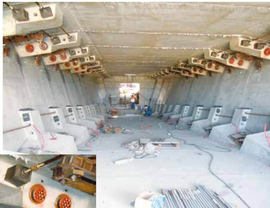
Viadotto Oglio, interno dell'impalcato in costruzione
