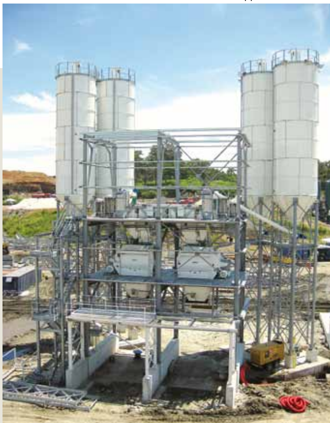
Durante la fase di costruzione, vista interna del doppio mescolatore
