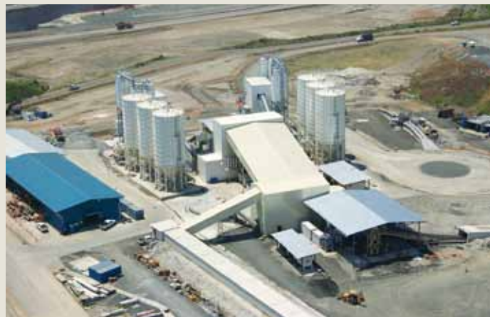
Sfondo con la lavorazione del canale e con nostro impianto sulla sinistra
