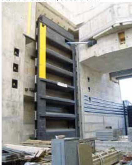
Particolare di una delle porte vinciane della conca di Uelzen II, in Germania
