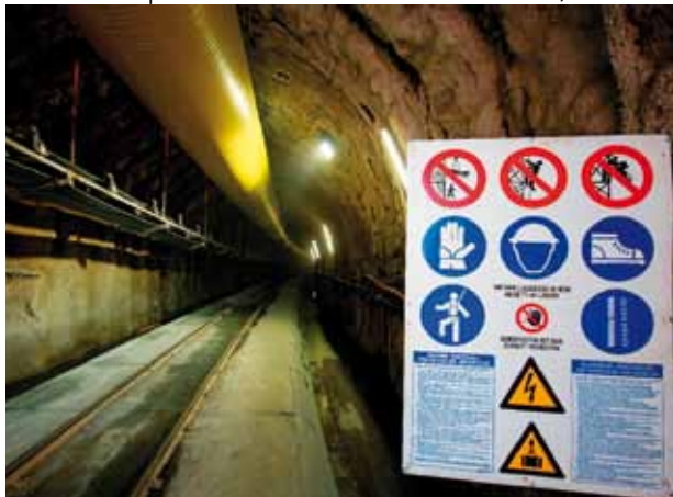
Il cunicolo esplorativo scavato dall'imbocco di Aica, in Italia
