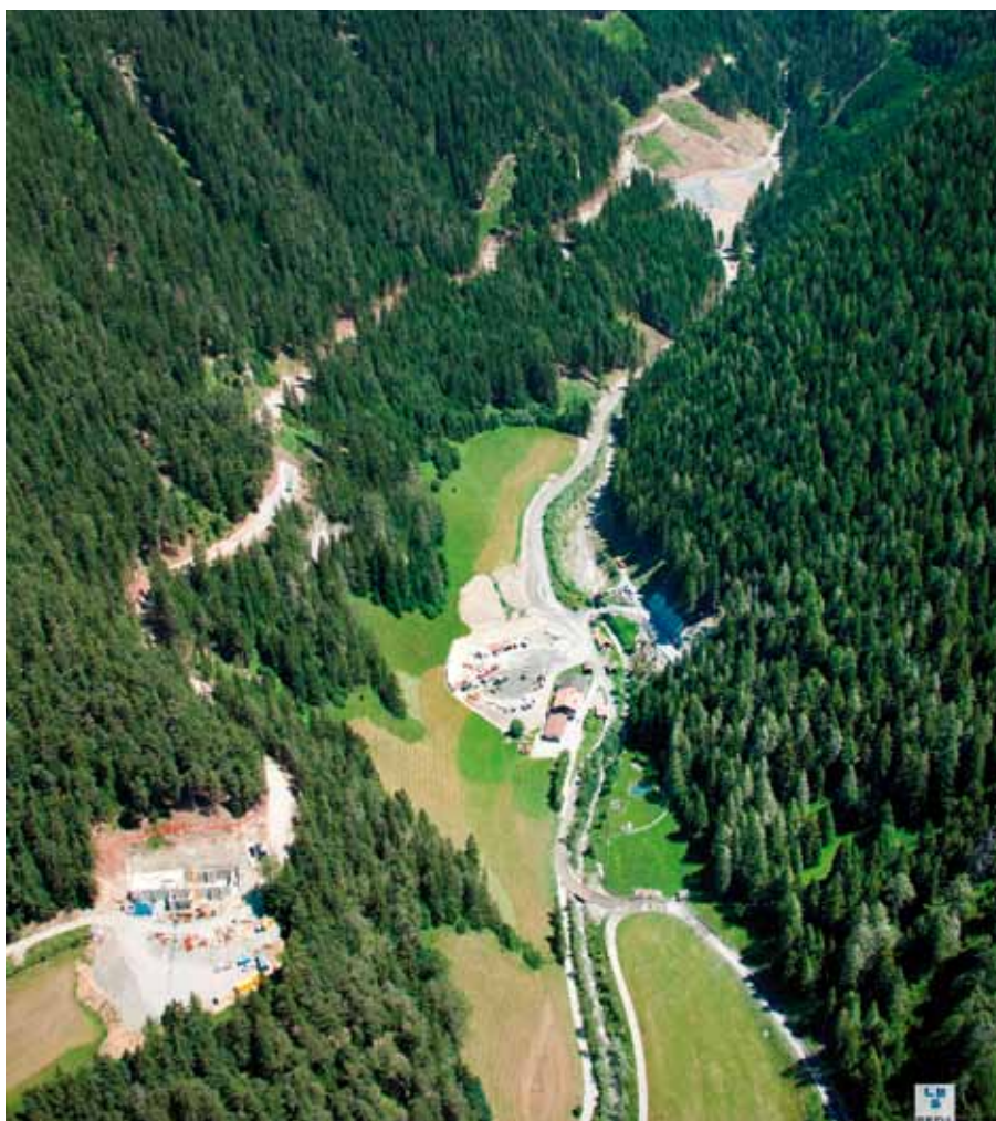
Veduta dell'imbocco a monte della galleria Padaster, realizzata per collegare direttamente la finestra di Wolf con la vicina area di deposito del materiale di scavo
