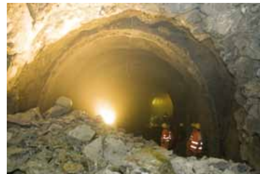
Caduta del diaframma della galleria che collega il cantiere di Aica con la zona di deposito di Hinterrigger, dove lo smarino viene trattato in impianti di frantumazione per la preparazione del calcestruzzo
