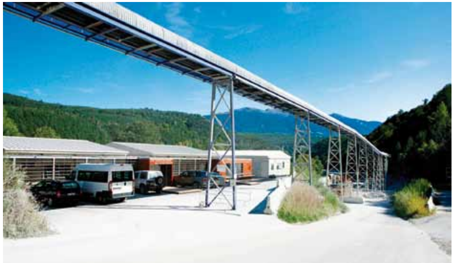
Particolare del nastro trasportatore in val di Riga, del cantiere di Aica, collegato alla zona di deposito di Hinterrigger
