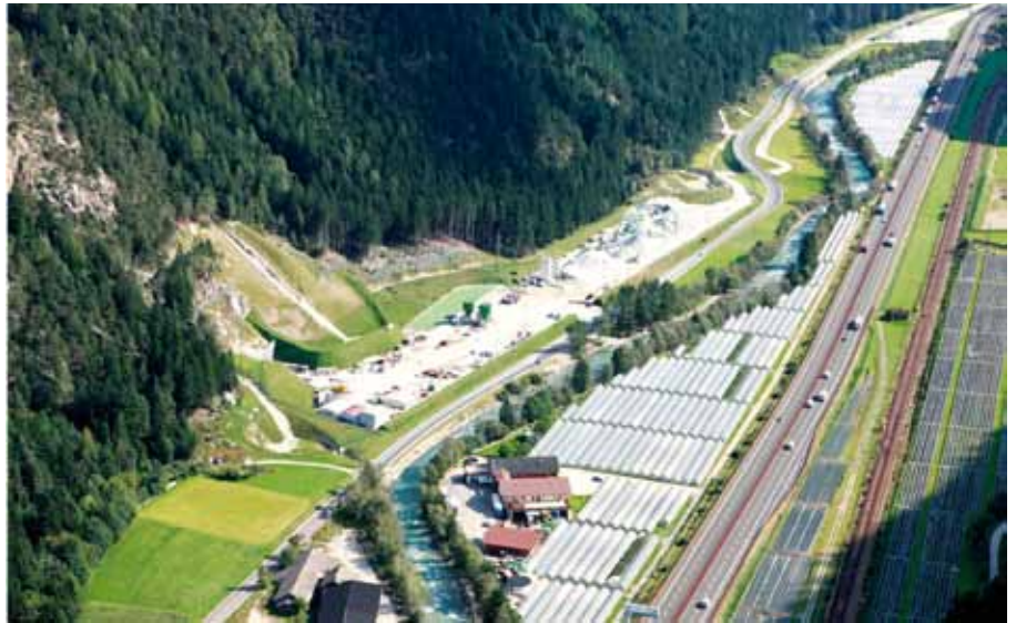
Veduta del cantiere di Mules, separato dall'autostrada da una serie di serre per la coltivazione delle fragole
