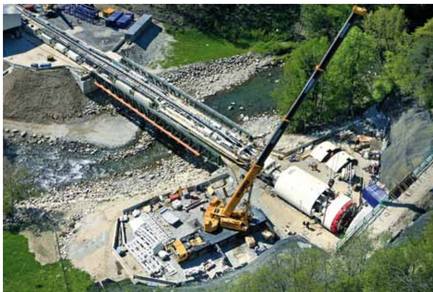
Vista della Tbm a doppio scudo utilizzata per lo scavo del cunicolo esplorativo, presso l'imbocco di Aica, in Italia, all'inizio dei lavori, nel 2008
