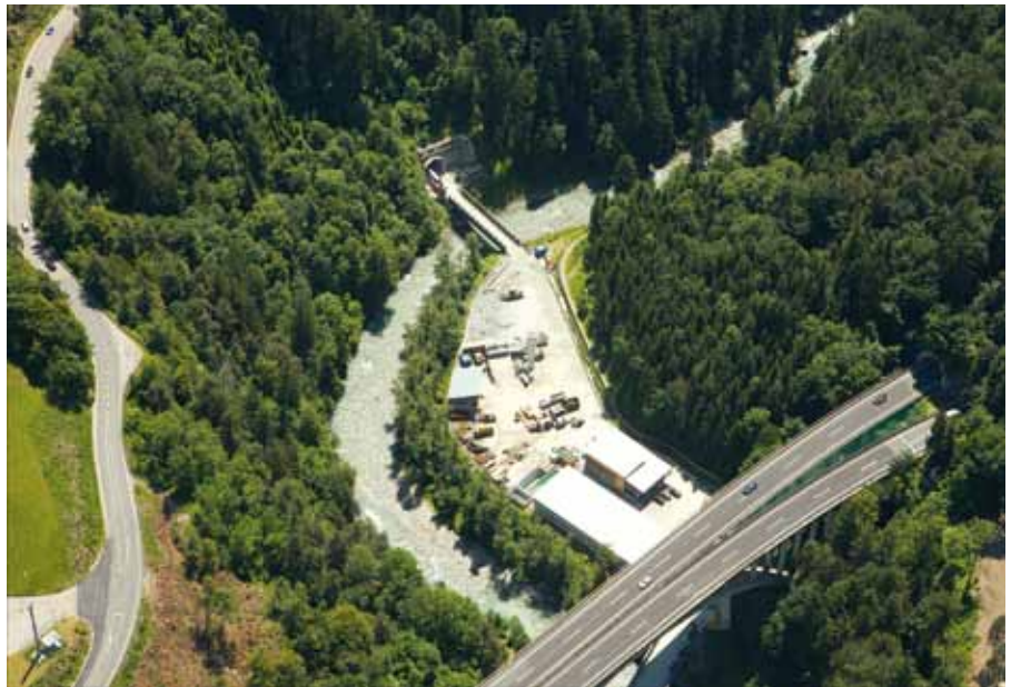
Veduta del cantiere di Ahrental
