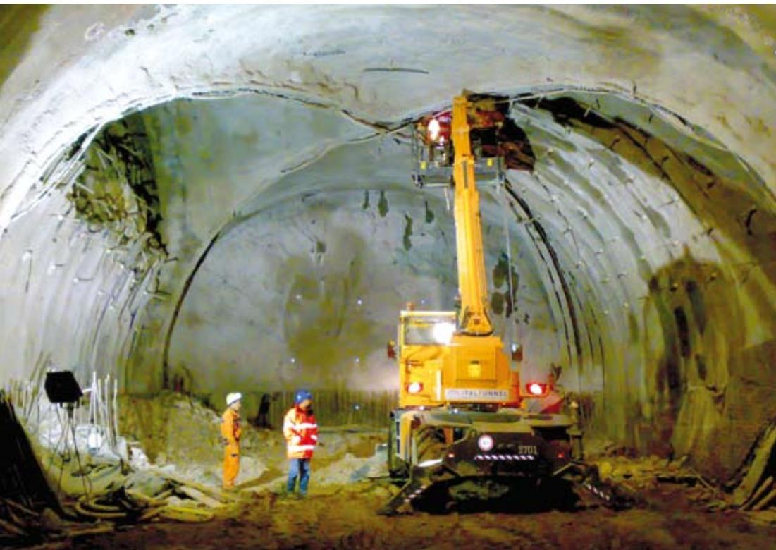
criteri di scelta ed applicazione delle sezioni tipo per ottimizzare la loro distribuzione in funzione del comportamento del contesto geologico, cioè della risposta deformativa, a tutto vantaggio della regolarità dell'avanzamento.
