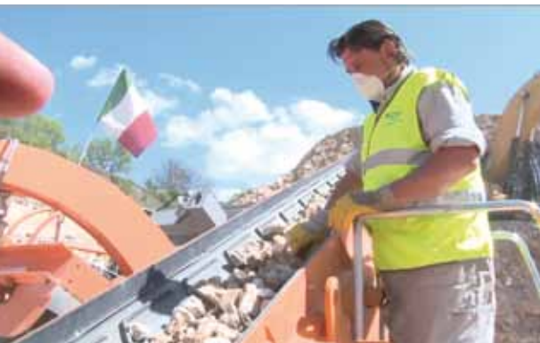
Una delle fasi di selezione delle macerie presso la cava ex Masci di Pontignano (AQ)
