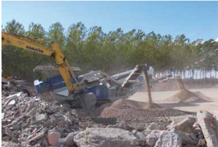
Particolare del Centauro 100.32 di Cams impegnato nella frantumazione e vagliatura delle macerie del terremoto presso la Acea Costruzioni di Mirandola (MO)
