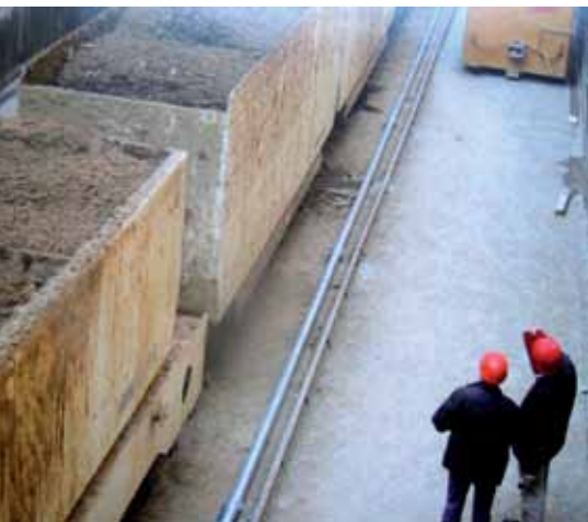
Operazioni di smarino terra scavata
