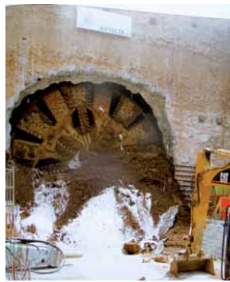
Un momento dello scavo meccanizzato: evidente l'impiego di schiume
