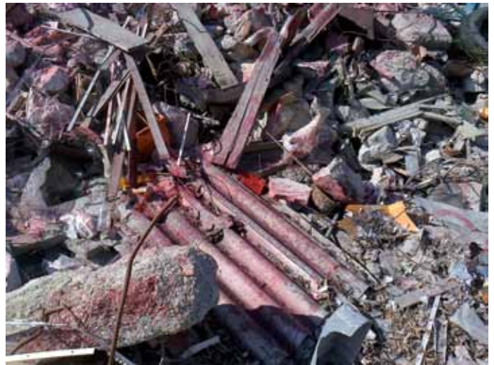
Amianto individuato in un cantiere e poi messo in sicurezza per il successivo smaltimento in impianto autorizzato
