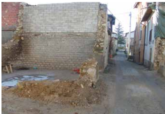
Una strada del centro storico dell'Aquila liberata dalle macerie dei crolli
