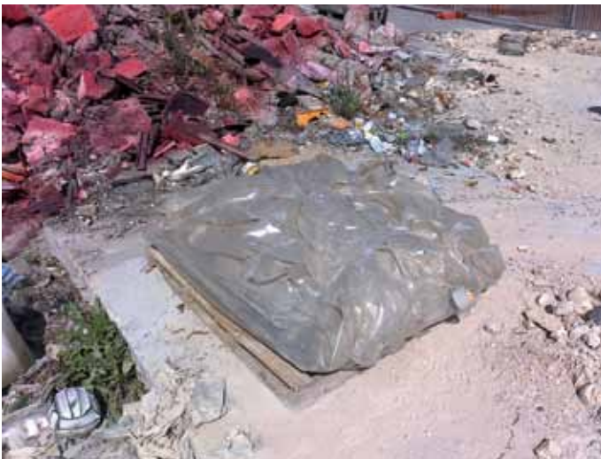
Amianto individuato in un cantiere e poi messo in sicurezza per il successivo smaltimento in impianto autorizzato
