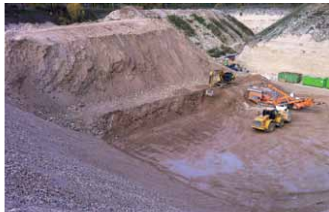
Particolare dell'ex cava Teges, già in fase di ripristino con le macerie del terremoto
