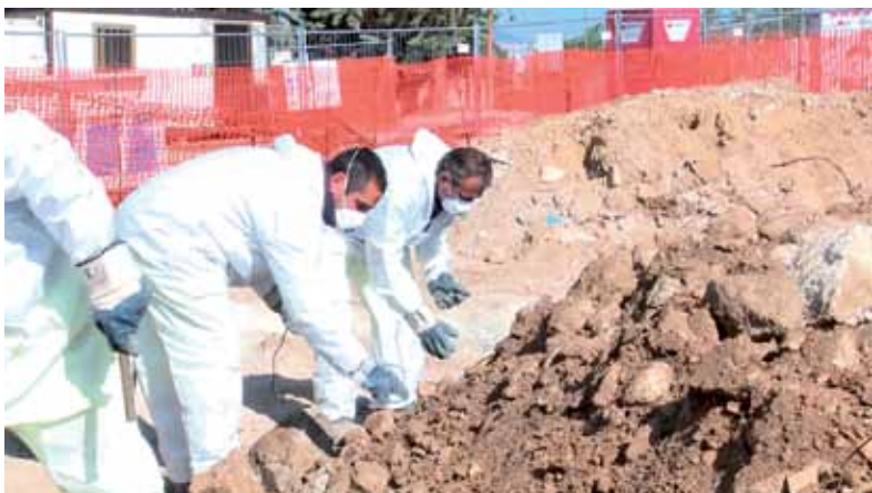
Particolari delle fasi di selezione manuale delle macerie effettuate nell'ex cava Teges
