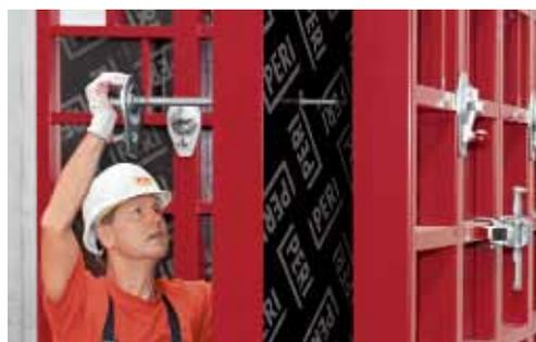
Maximo, con il tirante di ancoraggio MX messo in opera da un solo lato della cassaforma, è stato ancora una volta al centro dell'attenzione nel settore delle casseforme per pareti. L'ultima innovazione del sistema sono i tiranti di ancoraggio MX 18, impiegati in presenza di pressione particolarmente elevata del calcestruzzo fresco
