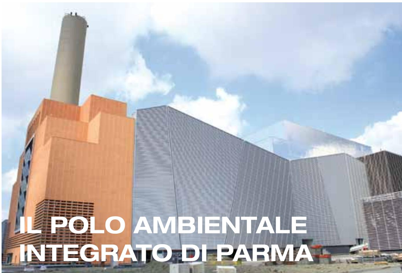
Il termovalorizzatore produrrà energia elettrica, pari al fabbisogno di circa 75.000 cittadini, ed energia termica per l'allaccio al teleriscaldamento di circa 38.000 cittadini ■ **TOMMASO SAVINA**
