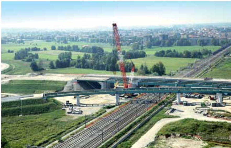
Vista aerea dello svincolo dopo il varo del 10 settembre. La gru Terex è ancora in posizione; in primo piano la rampa Brebemi, sullo sfondo la via Sud già varata e già aperta al traffico di cantiere
