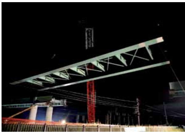
Sequenze delle operazioni di varo [Fase 3] del viadotto sopra la ferrovia, 10 settembre 2013
