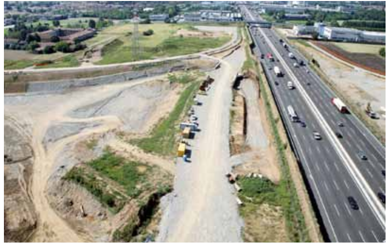
Lavori presso lo svincolo di interconnessione fra Teem e A4
