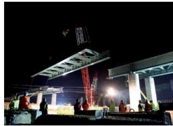
Sequenze delle operazioni di varo [Fase 3] del viadotto sopra la ferrovia, 10 settembre 2013
