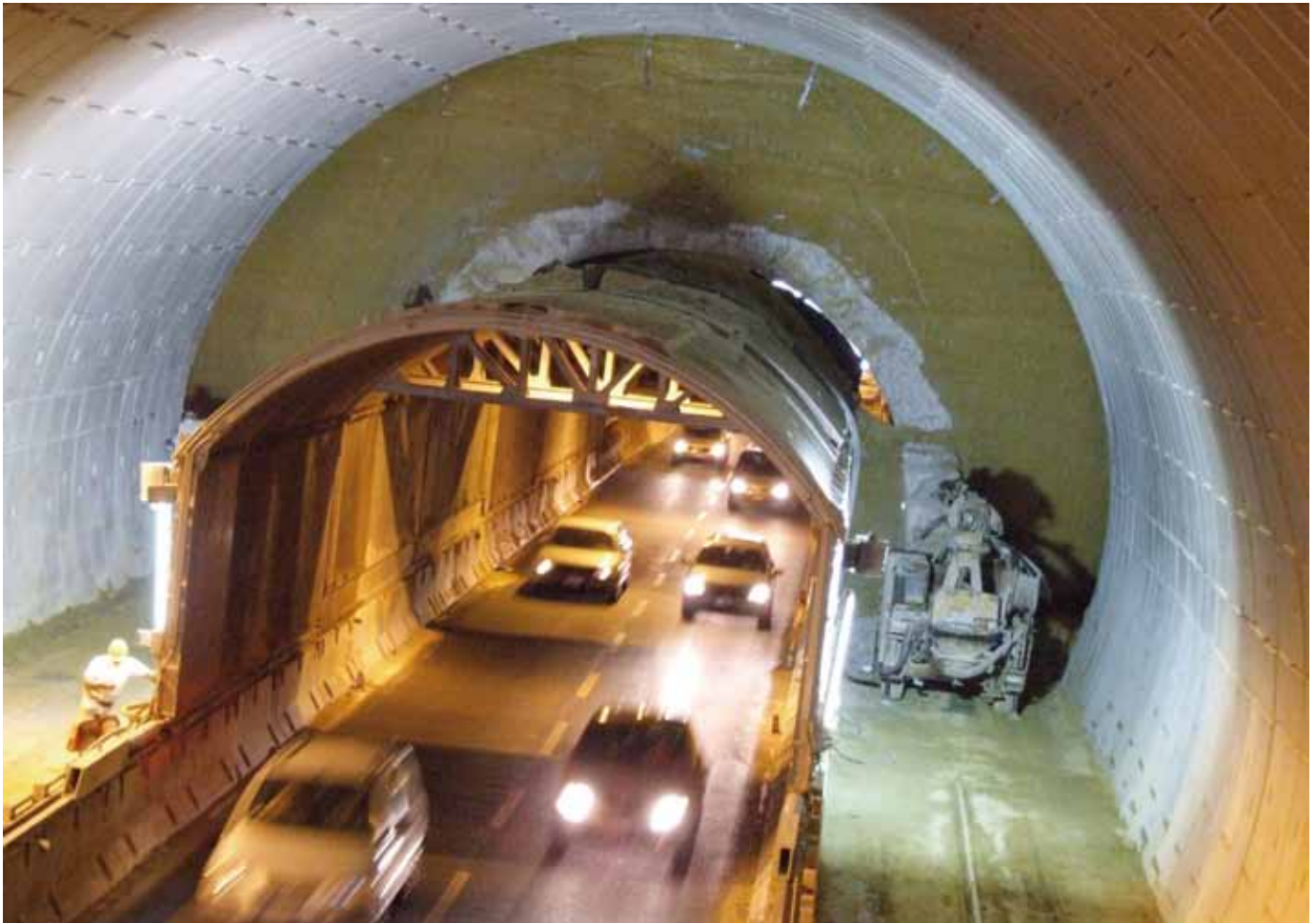
Figura 2 - Galleria Nazzano: il traffico protetto dallo scudo d'acciaio di protezione mentre si procede all'ampliamento della vecchia galleria
