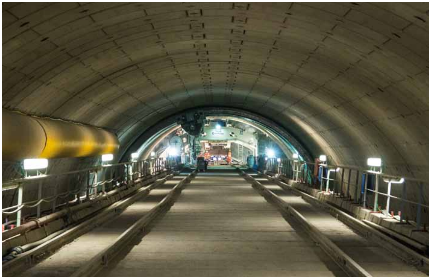
Figura 6 - Galleria Montedomini: l'area di cantiere sopra lo scudo
