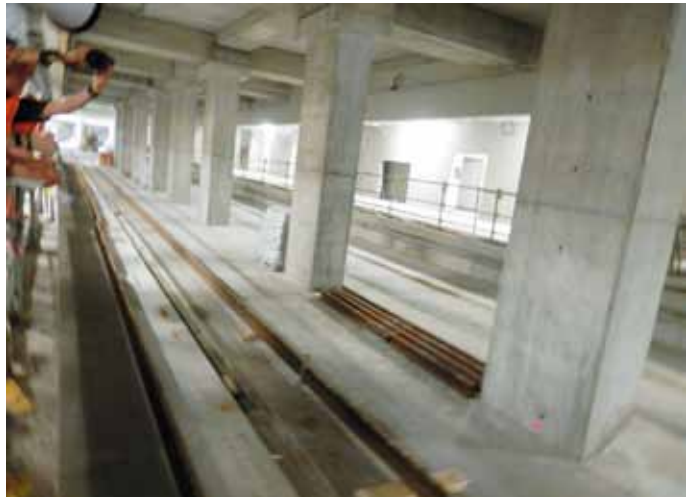
Stazione di San Siro, zona banchina
