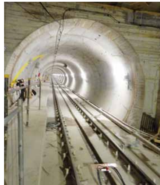
Una delle gallerie terminata alla stazione Lotto
