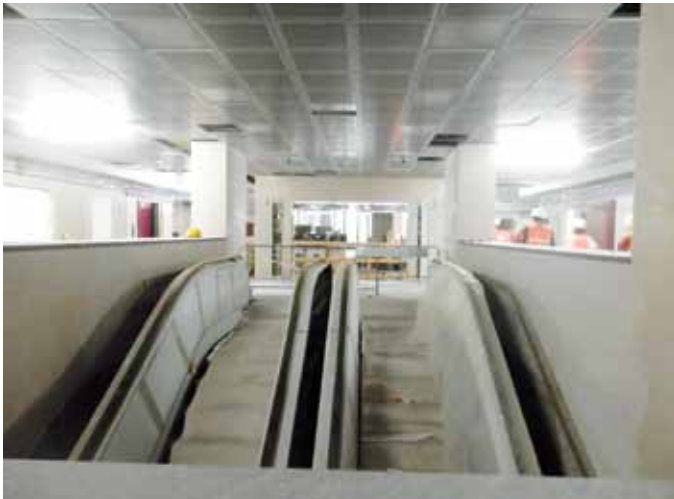
Visita in cantiere
