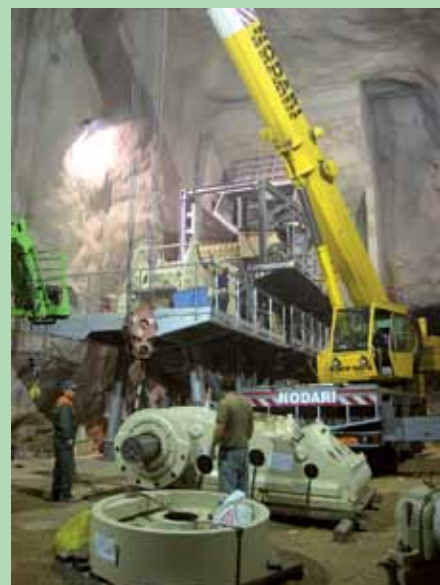
Montaggio dell'impianto in sotterraneo
