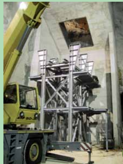
Montaggio dell'impianto in sotterraneo
