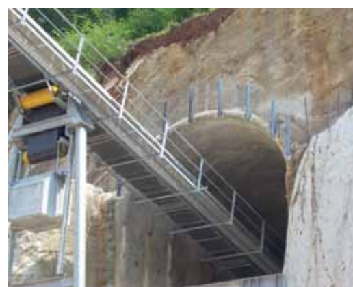
Particolare dell'imbocco della galleria
