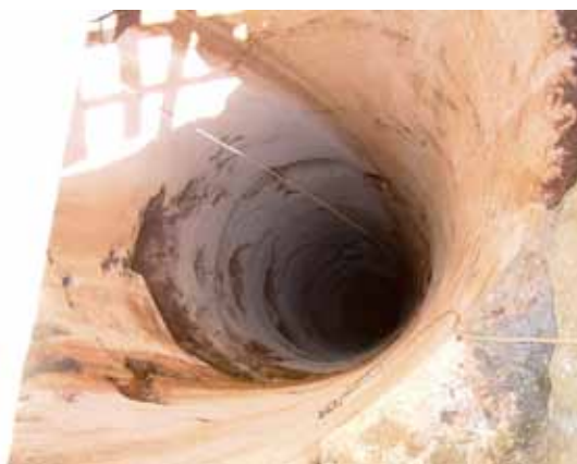
Particolare del fornello di diametro 3,6 m e lunghezza 85 m
