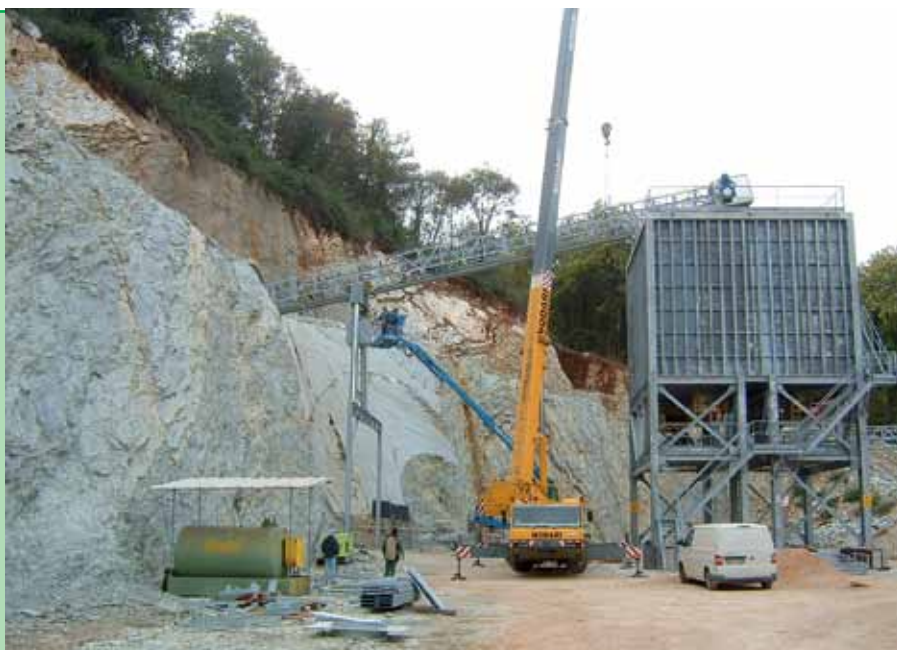
Montaggio dell'impianto sul piazzale esterno
