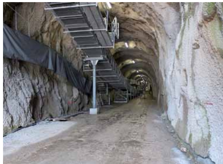
Galleria e nastro di estrazione principale
