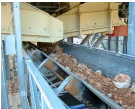
Particolare alimentatori a cassetto sotto la tramoggia di caricamento automatico
