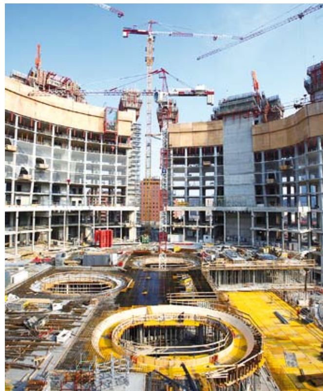
Foto di Maurizio Pardo, Holcim Aggregati Calcestruzzi Srl
