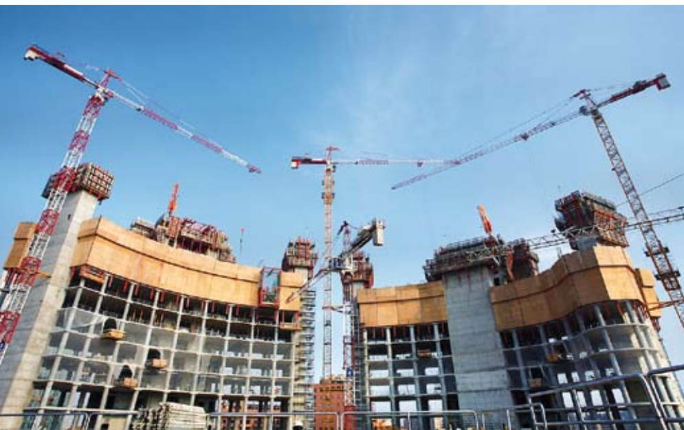
Foto di Maurizio Pardo, Holcim Aggregati Calcestruzzi Srl
