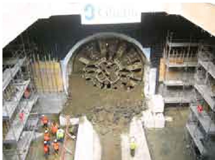
Figura 25 - L'arrivo della TBM in Stazione Nizza
