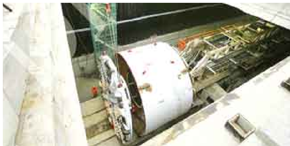
Figura 2 - Il calaggio della testa TBM-EPB in stazione Marconi
