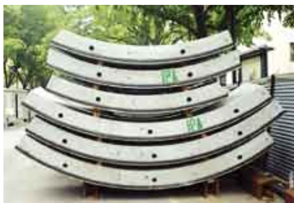
Figura 10 - I sei conci prefabbricati che formano un anello completo per il rivestimento della galleria 2
