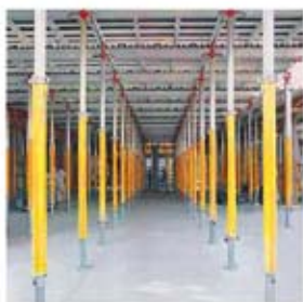
Figura 2 - Esempio di puntellamento di una soletta preventivamente all'inizio dei lavori di demolizione e calcolo della disposizione e spaziatura dei puntelli per sorreggere i carichi di progetto
