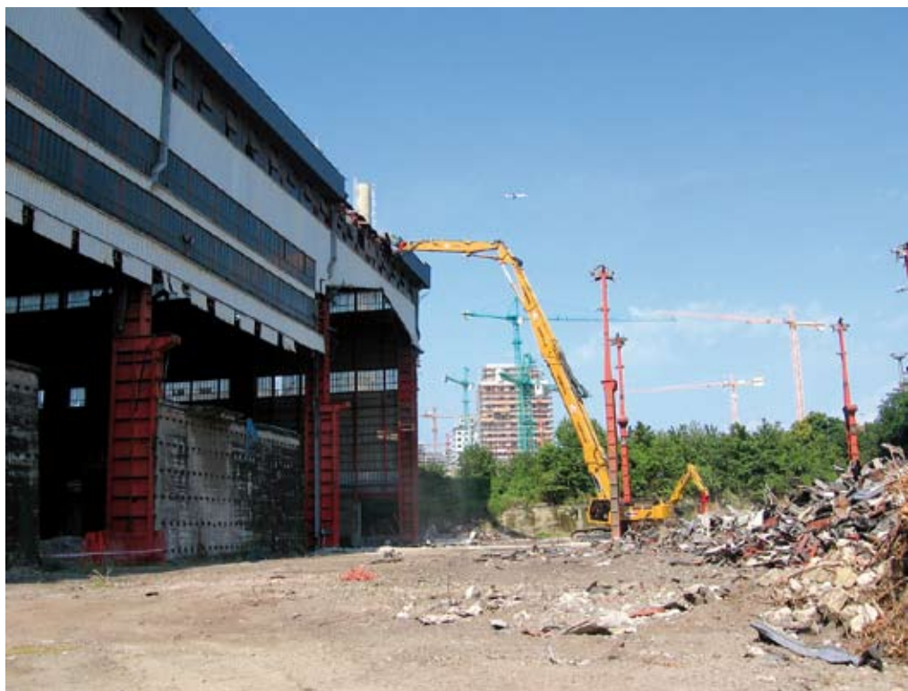
Figura 4 - Corretto approccio di una demolizione con escavatore dotato di braccio super long demolition con il quale vengono garantite le distanze di sicurezza dal manufatto in demolizione
