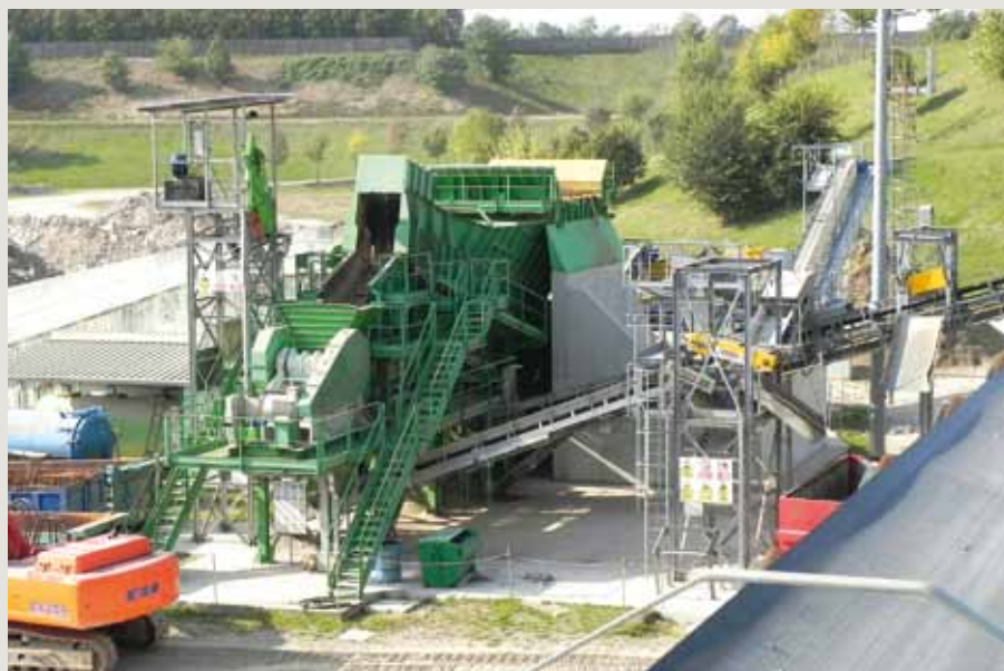
Impianto di Trevignano
